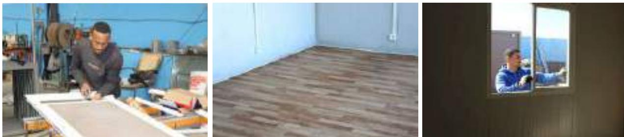
Este material de construcción, constituido por una capa de aislamiento entre dos láminas de material perfilado, ofrece resistencia al fuego, aislamiento térmico e impermeabilidad. Ligero, permite adecuar los edificios a las normas con rapidez, tales como estancias o viviendas, por ejemplo, así como cocinas y aseos (véase las fotos).
